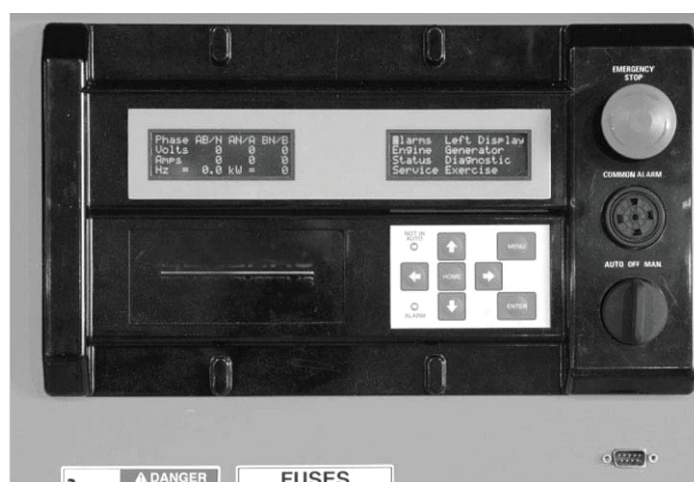
РИСУНОК 3-2. Интерфейс панели управления H-100
